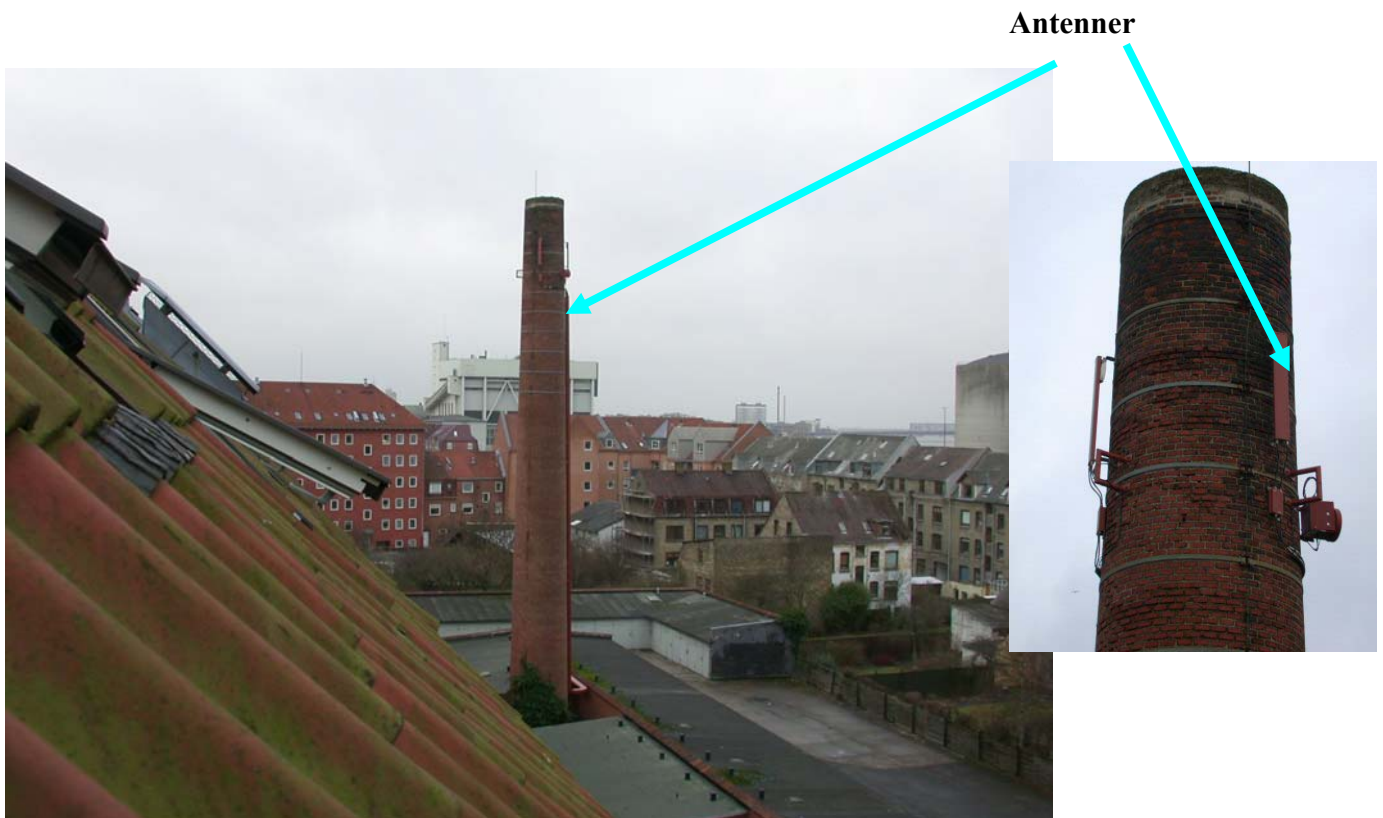
Figur 7. 3G antennemast set fra beboelse.
